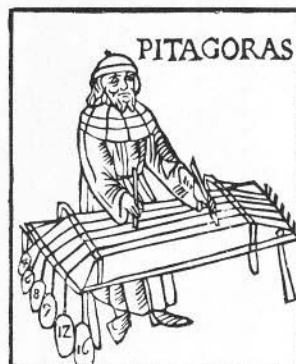
La prova dels cables en tensió
