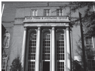
Edifici de l'Institut Nacional de Física y Química de la Junta para la Ampliación de Estudios (JAE), actualment Consell Superior d'Investigacions Científiques (CSIC)
